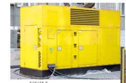
発電機〔筐体内張り吸音材・断熱材(耐熱性)〕 Power generator
